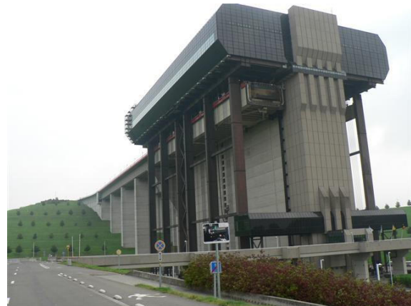
FIGURE 11.10 – ascenseur fluvial de Strepv
